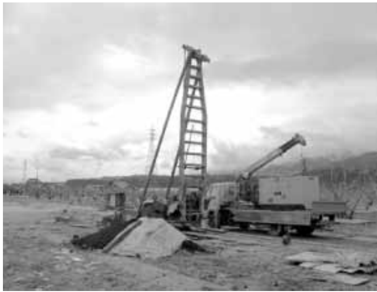
河野地区 井戸の掘削
